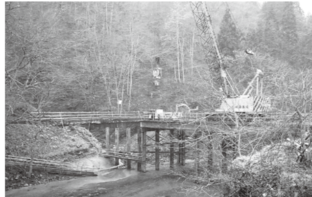
関用水路工事（仮橋設置）
