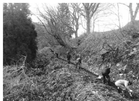
▲用水路の泥上げ作業
