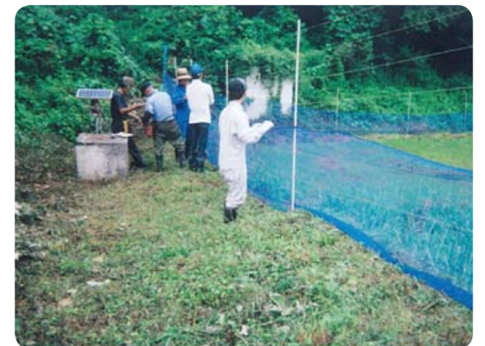
有害鳥獣防止対策・電気柵の設置作業(関集落)
