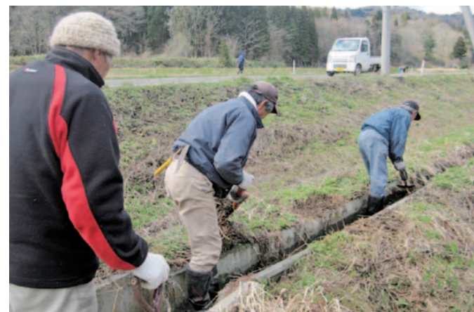
共同による用水路の泥上げ作業（峠田集落）
