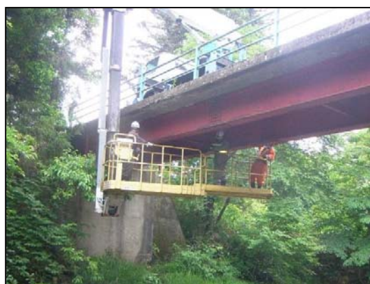
写真 - 1 橋梁点検の状況
