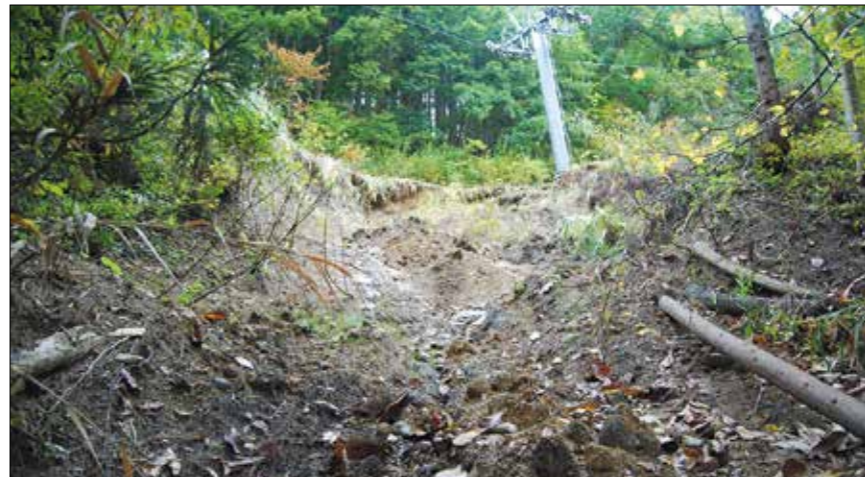
▲七ヶ宿スキー場内崩落箇所
