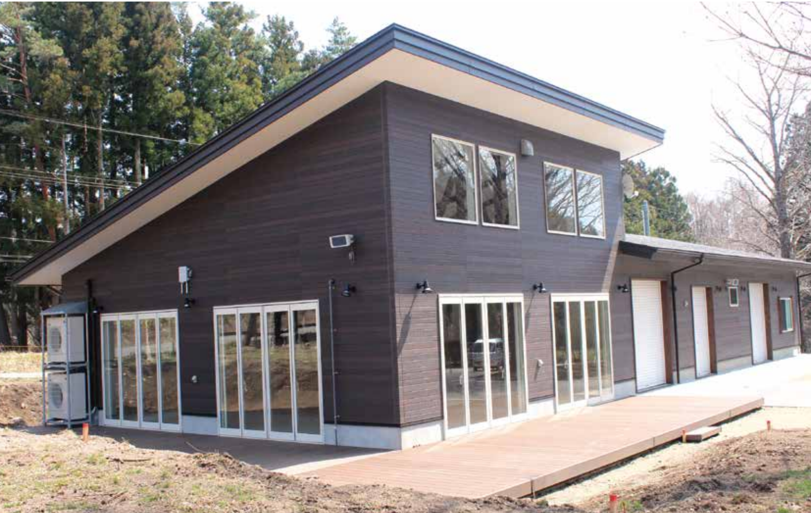
南蔵王やまびこの森グランピング交流棟(工事中)
