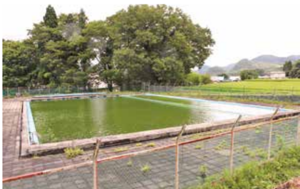
▲現在の町民プール全容
