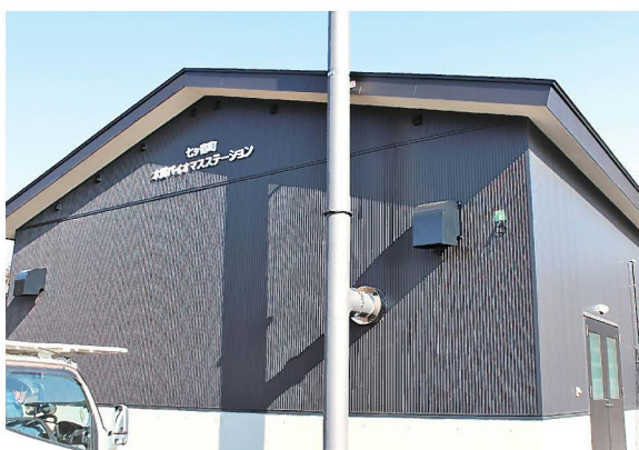
▶ 木質バイオマス施設
