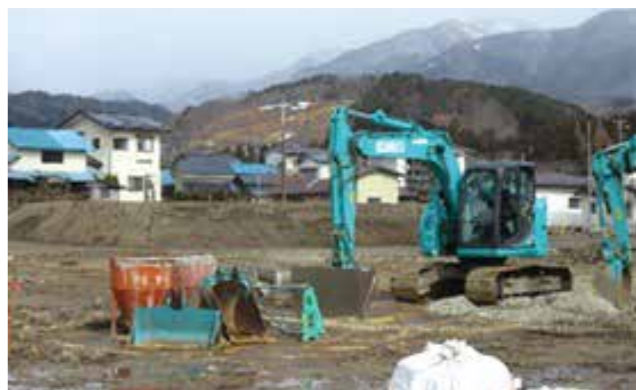
▲基盤整備工事中
