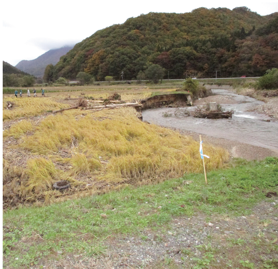
▲台風19号被害現場（大石河原）
