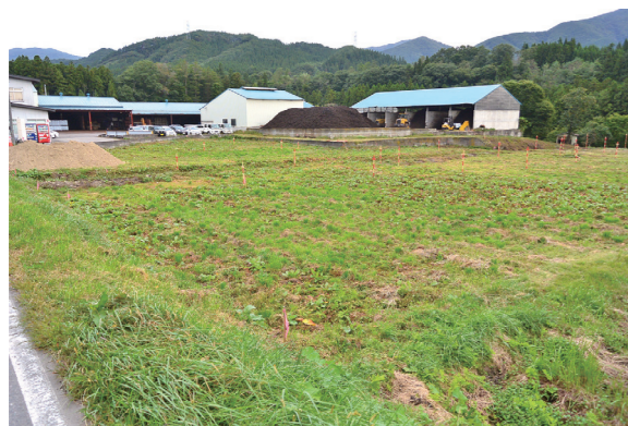
▲蒲木造成工事現場
