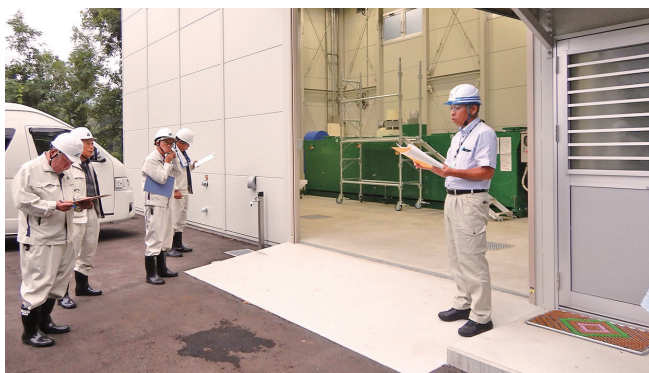
▲有害鳥獣処理施設建設工事
