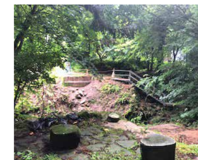
▲橋撤去後の現地
