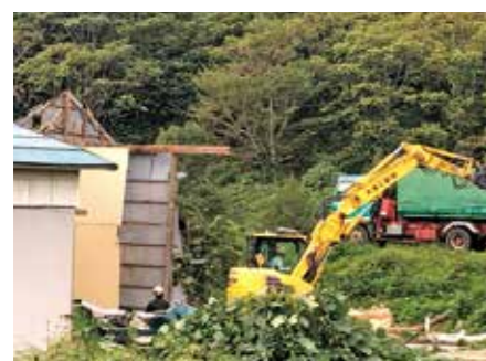
▲家屋解体風景
