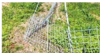
▲ワイヤーメッシュ雪害破損箇所
