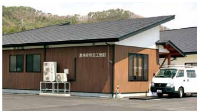
▲道の駅（加工施設）
