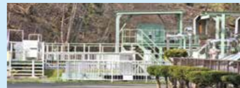
▲七ヶ宿町下水処理場
