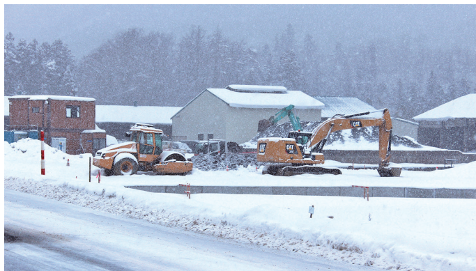
▲チップ生産施設工事中
