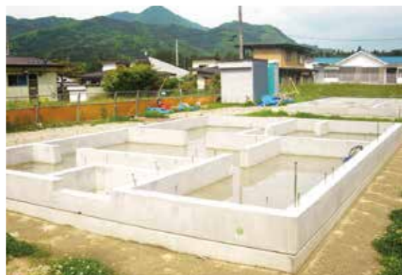
▲建設中の公営住宅基礎
