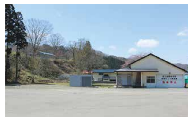
▲除雪車格納庫建設予定地
