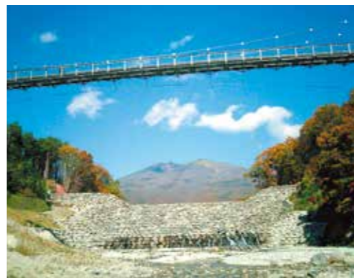
▲やまびこ吊り橋
