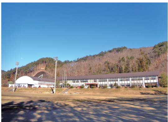
▲築45年経過の中学校校舎
