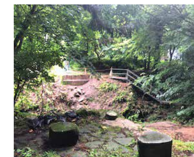
▲橋撤去後の現地
