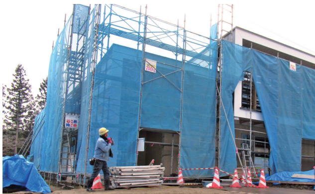
▲建設中の保育所
