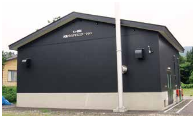
▲木質バイオマス施設
