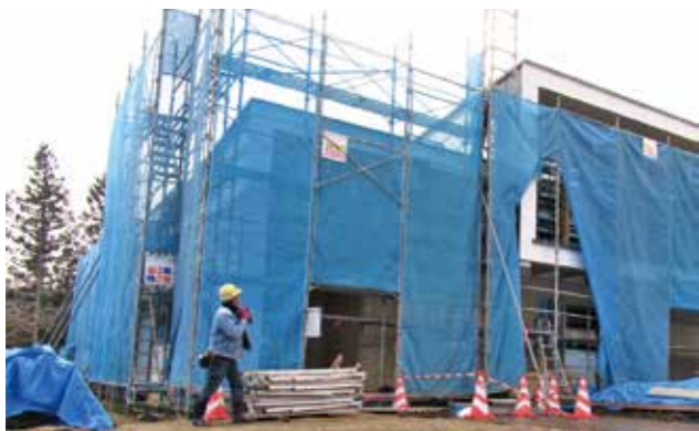
▲建設中の保育所
