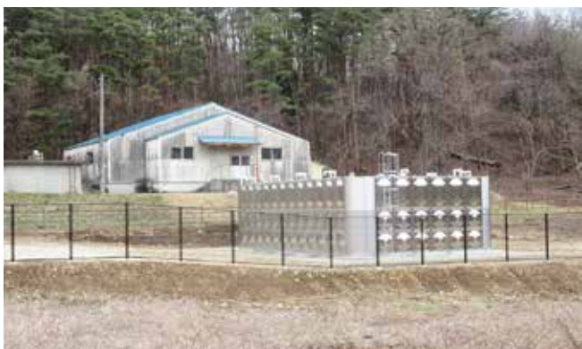
▲関浄水場配水池
