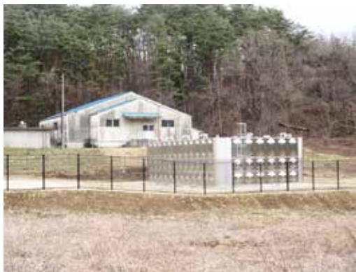
▲関浄水場配水池
