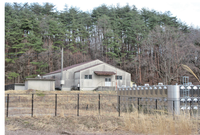
▲簡易水道施設
