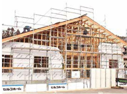
▲入浴施設建設中
