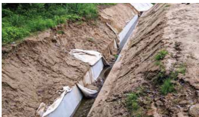
▲東寺入沢工事現場
