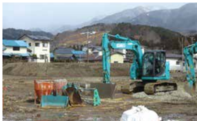
▲基盤整備工事中
