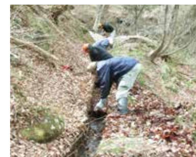
▲共同による用水路の泥上げ作業(滑津集落)
