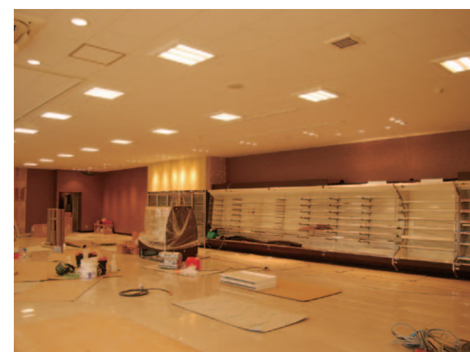
▲店内工事の様子
