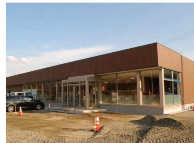
▲工事が進む店舗
