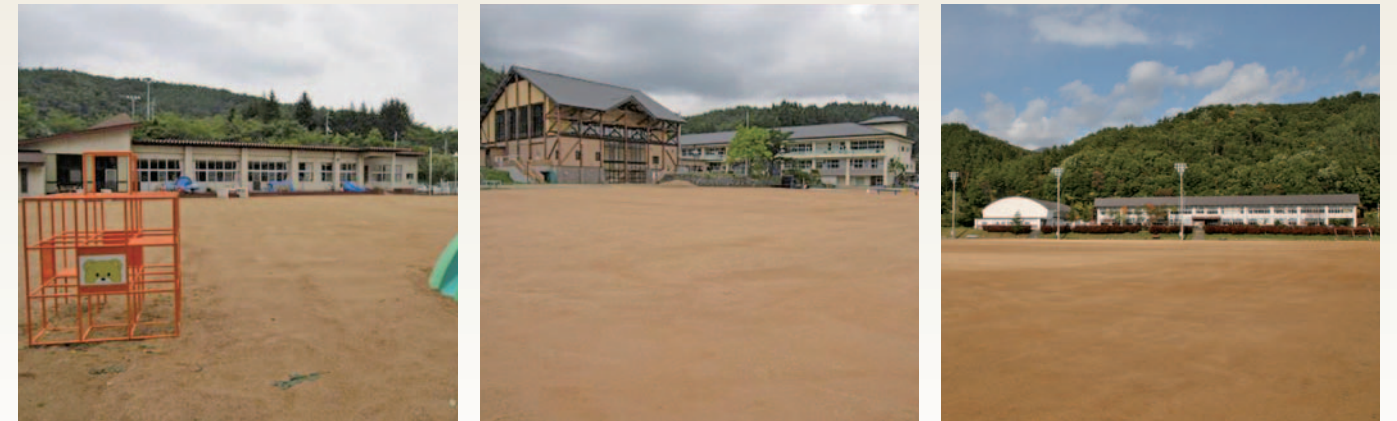
除染により覆土された関保育所（左）、関小学校（中央）、町民グラウンド（右）
