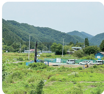
▲建設開始の様子
