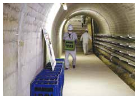
▲地下95mの監査廊に運び込む様子
