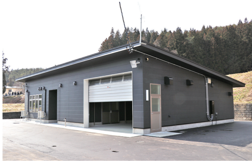
▲新しく完成した防災備蓄倉庫
