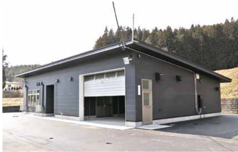
▲新しく完成した防災備蓄倉庫
