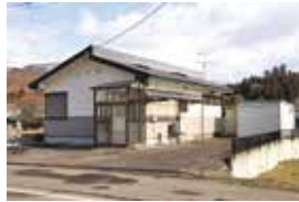
▲活性化センター 向かい側です
