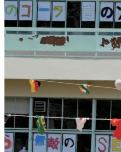
修繕が必要な校舎
