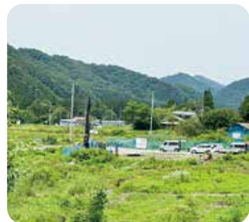
▲建設開始の様子
