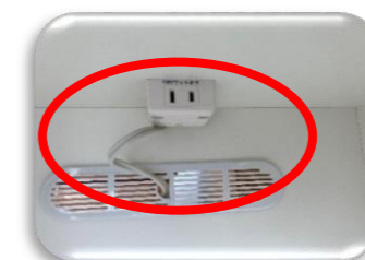
【コンセント・ケーブル】
