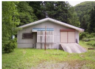
茂ヶ沢 配水池
