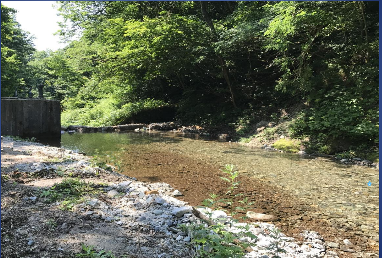
関浄水場 取水施設
