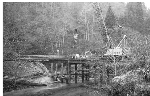
関用水路工事（仮橋設置）
