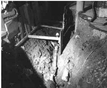
老朽化した水道管の復旧
